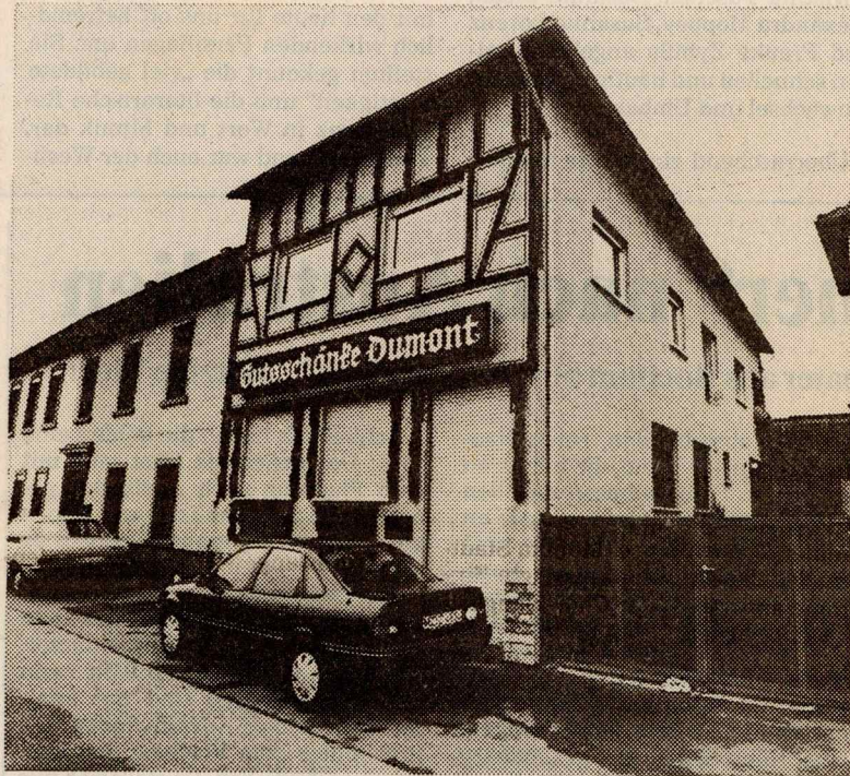
Große Umbauarbeiten sind nicht erforderlich, um aus der ehemaligen Guttschänke einen Kindergarten zu machen. Bild: Volker Oehl
